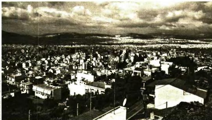
Το υπουργείο Εσωτερικών εξετάζει τον τρόπο με τον οποίο θα ενταχθούν στη νέα ρύθμιση οι χιλιάδες πολίτες που καλούνται να πληρώσουν αυτή τη στιγμή αναδρομικά δημοτικά τέλη έως και 14 ετών
