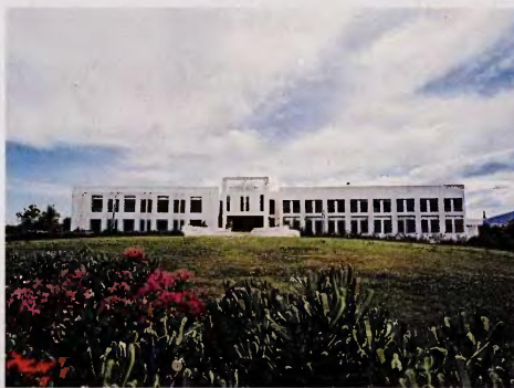
Το ΙΤΕ διαθέτει επτά ερευνητικά Ινστιτούτα, τα πέντε εκ των οποίων εδρεύουν στο εικονιζόμενο κεντρικό κτίριο στο Ηράκλειο Κρήτης.
