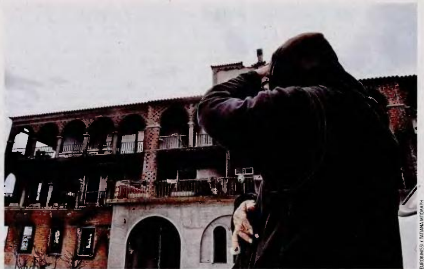
Η πυρκαγιά στο Λύρειο Ιδρυμα, στον Νέο Βουτζά, άφησε πίσω της στάχτη και καταστροφή. Η επιθυμία όμως «να (ξανα)γίνουν τα πράγματα καλύτερα από πριν» παραμένει ζωντανή.
