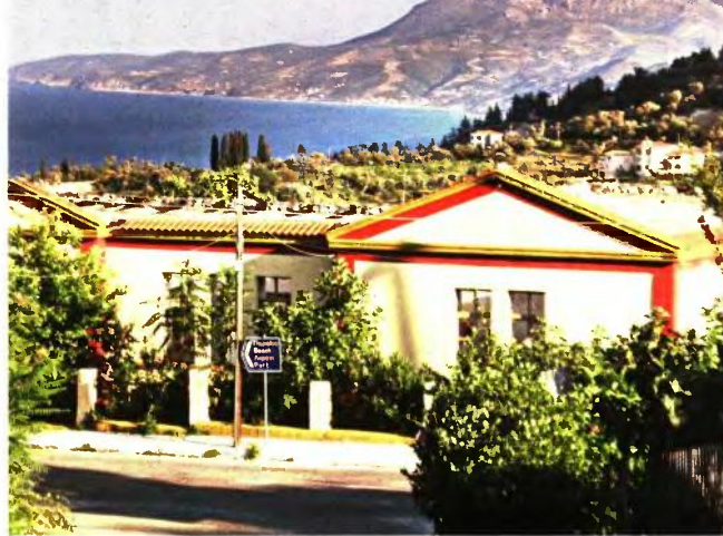
Το σχολικό κτίριο με την καμένη στέγη. Δίπλα, κατεστραμμένη αίθουσα
