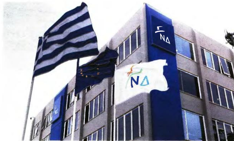
«Με το Συνέδριο ερχόμαστε για να δηλώσουμε έτοιμοι να αναλάβουμε τη διακυβέρνηση της χώρας, έχοντας επισημάνει πως κάθε επιπλέον ημέρα παραμονής των κ. Τσίπρα και Καμμένου στην εξουσία είναι ημέρα χαμένη για την Ελλάδα», τονίζουν πηγές της Ν.Δ.
