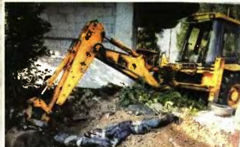
Από επιχείρηση της Ασφάλειας Δυτικής Αττικής στο Ζεφύρι, όπου χρειάστηκε εκσκαφές για να βρεθούν δεκάδες θαμμένα παράνομα όπλα
