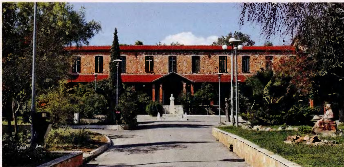
Σήμερα λειτουργούν μόλις δύο από τα έντεκα κτίρια του Γηροκομείου Αθηνών, καθώς τα υπόλοιπα δεν είναι αδειοδοτημένα.
